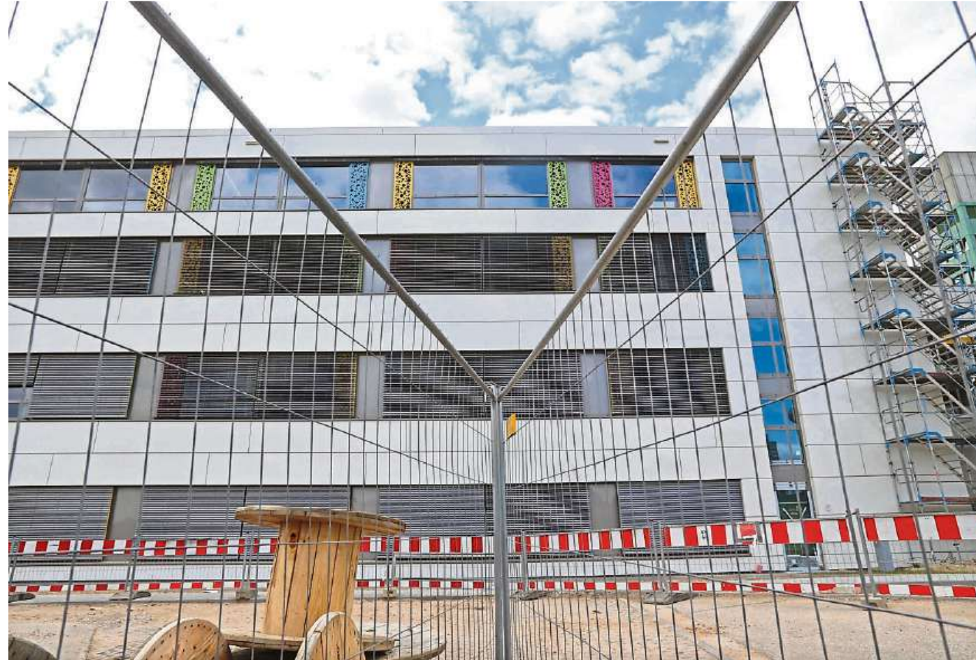
Nach einem Wasserschaden 2016 verzögert sich die Einweihung des Mutter-Kind-Zentrums voraussichtlich bis ins Jahr 2019. Archivfoto: pa/Stumpf
